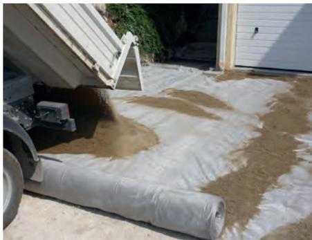
Le Batigeo est un géotextile spécialement conçu pour les voies d'accès à un pavillon, un garage, un parking individuel, la VRD et les terrassements. Il permet la traficabilité, la pérennité des ouvrages, la propreté des chantiers avec un encombrement minimal.
