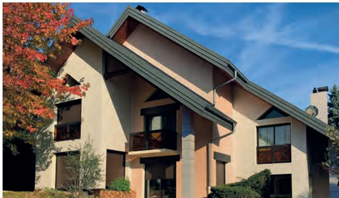
Bardage composite, 90 % fibre de bois. Haute densité (760 KG/M3). Faiblement imprégné de résines. Revêtu de 2 couches de peinture latex acrylique. Fixation par clous inox (pas de vis). 100% recyclable avec système de montage Tru-Align pour un assemblage rapide, précis et très résistant. Avis technique du CSTB. Conçu et fabriqué au Canada pour une durabilité extrême.
